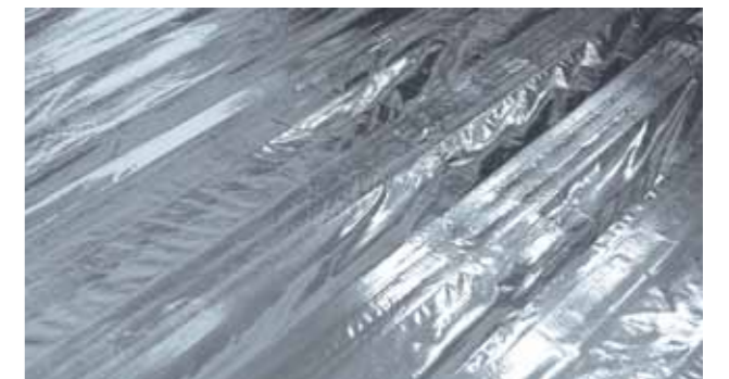
14 pav. Membrana TECHNOELAST VB 500 SELF, priklijuota ant profiliuoto lakšto
