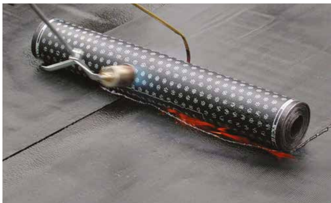
6 pav. Ištirpintos polimerinės – bituminės masės „banga“
